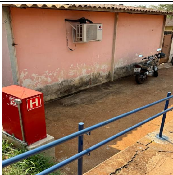
Paredes desgastadas e com infiltrações (foto 02).
