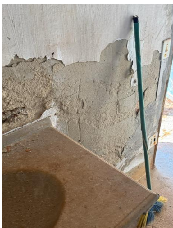
Parede corroída.
