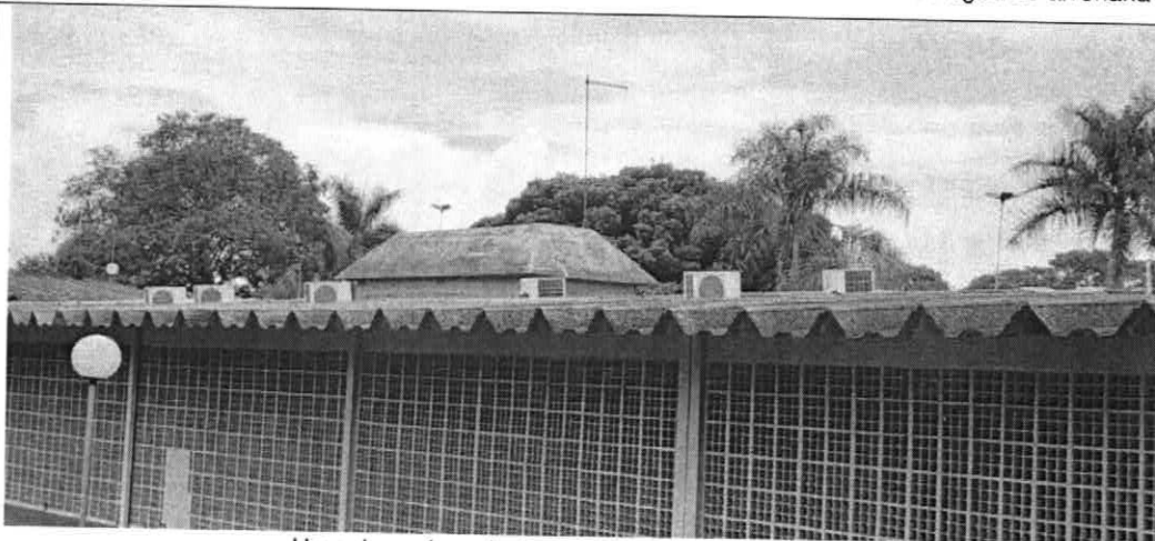
Uma das caixas de água da unidade sobre o telhado
