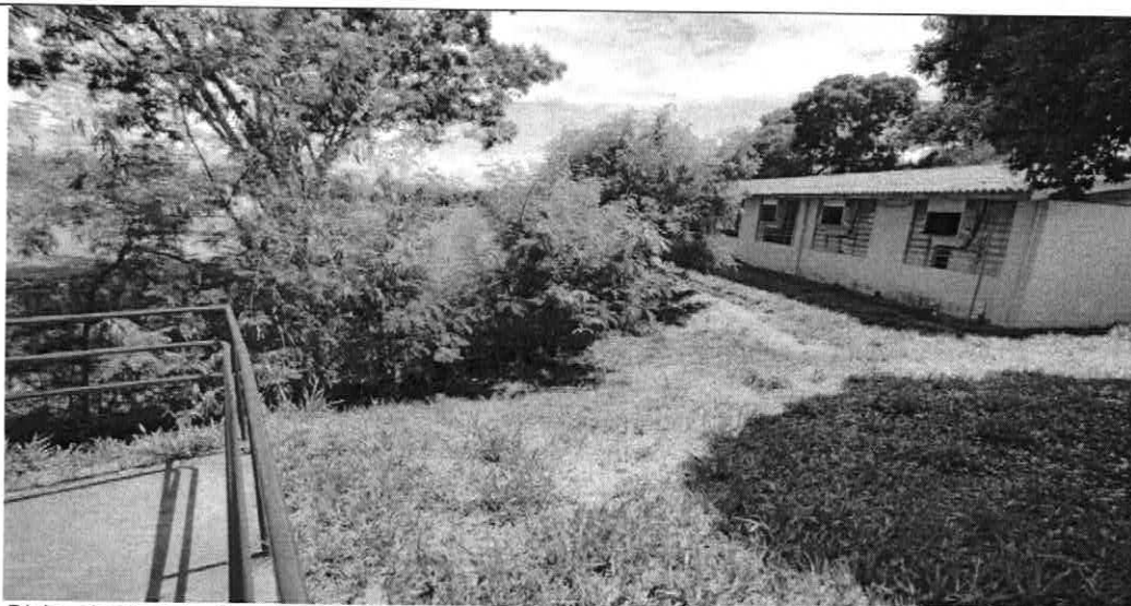
Divisa das instalações da unidade através de alambrado com vegetação próxima, que permite entrada de insetos e outros animais, inclusive peçonhentos
